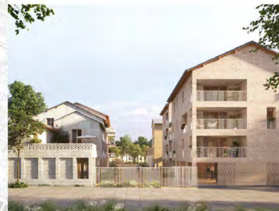
88 logements à la plaine de Montjean, Palast Architectes, Rungis
